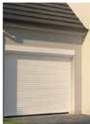
Pose en tunnel extérieure
